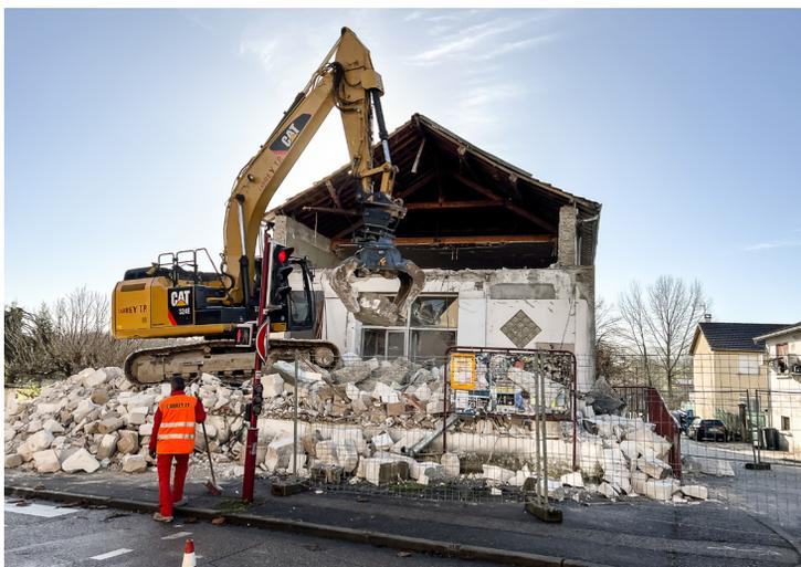
Les travaux de démolition de l'ancienne salle des fêtes ont débuté au mois de décembre. Ils se sont déroulés en deux temps, le premier consistant à supprimer les isolants dans le plafond et à trier les matériaux, en sélectionnant ceux qui pourraient être réutilisés.
